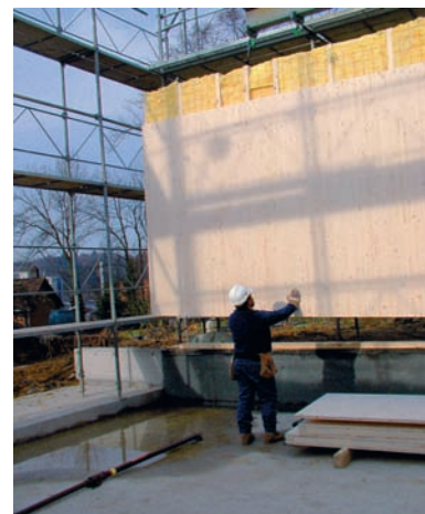
3-schichtige Blockholzplatten bilden als innere Schalen die Aussteifungen und dienen als Auflager für Geschossdecken und Dach. Fotos: Pius Schuler AG
