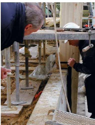
Der Aufbau verlangte wegen der schrägen Wände ein besonders durchdachtes Vorgehen.
