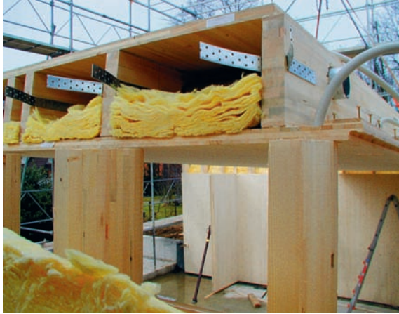
Die Zwischenböden wurden als Hohlkastenelemente ausgeführt (links). Das Verbundprofil (Schuler-Kralle) ermöglicht einen fugenfreien Zusammenbau einzelner Blockholzelemente (rechts).
