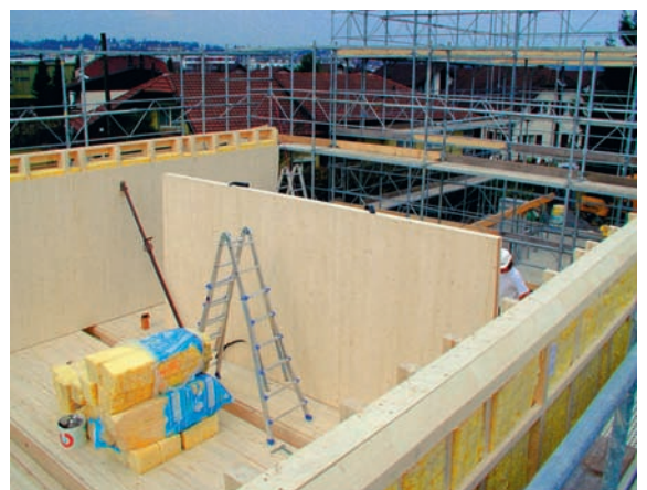
Isolationsmatte und Holz als ideale Kombination für eine gute Energieeffizienz (oben). Die Aufrichte des Rohbaus im Villenquartier dauerte nur zwei Tage.
