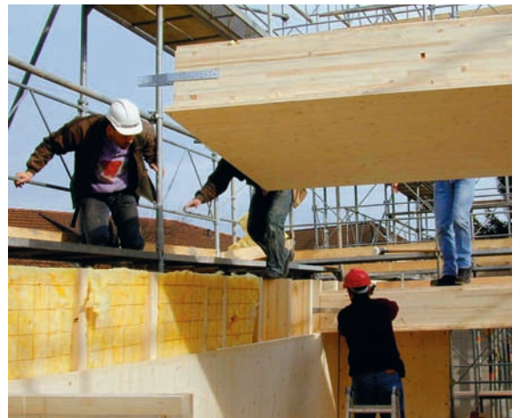
Isolationsmatte und Holz als ideale Kombination für eine gute Energieeffizienz (oben). Die Aufrichte des Rohbaus im Villenquartier dauerte nur zwei Tage.
