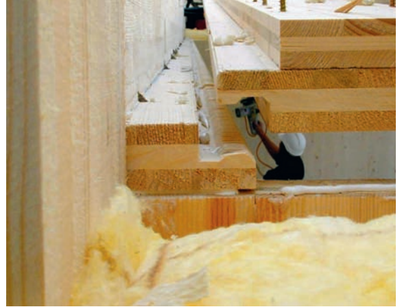
Die Zwischenböden wurden als Hohlkastenelemente ausgeführt (links). Das Verbundprofil (Schuler-Kralle) ermöglicht einen fugenfreien Zusammenbau einzelner Blockholzelemente (rechts).
