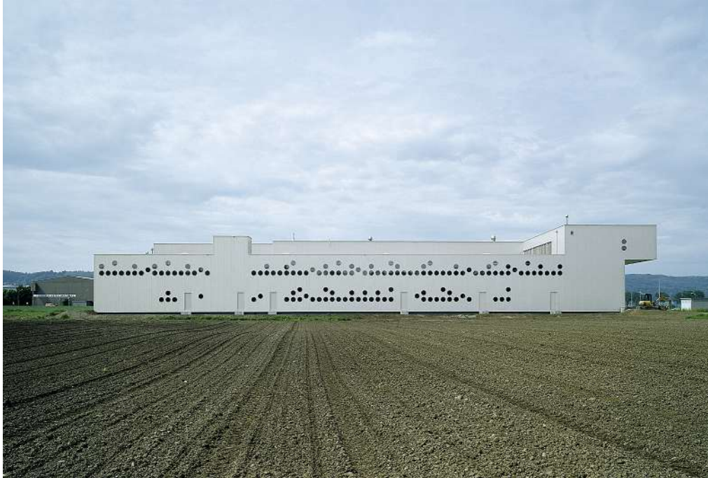
Nordöstliche Längsfassade mit Lochfenstern
