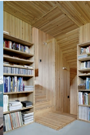
<47_ Die Räume sind an den Podesten der vierläufigen Treppe angedockt.
