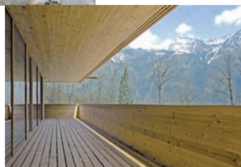
>49_ Die horizontale Dachverschalung begrenzt den Blick.
