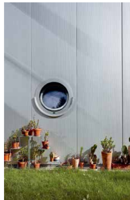
In die industriell gefertigten Paneele lassen sich problemlos auch runde Fenster schneiden.
