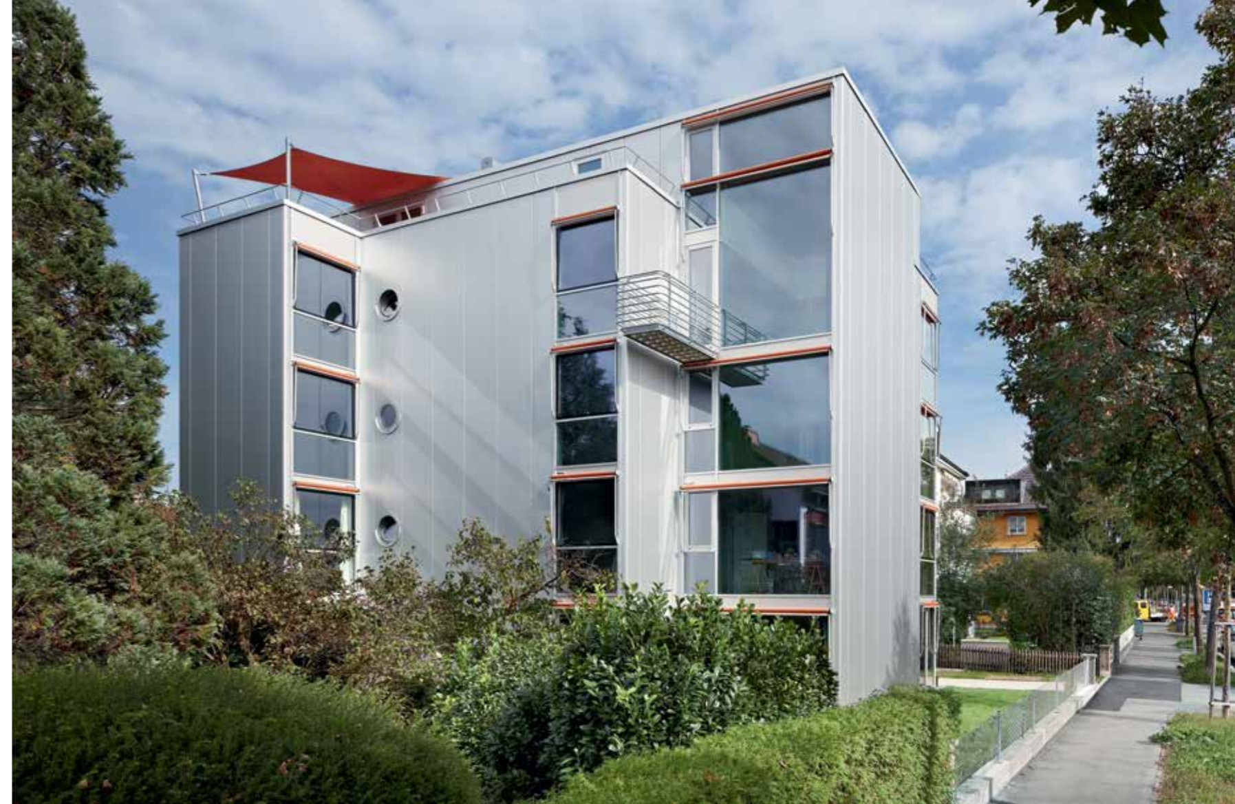
Haushohe Paneele: Die Sandwichelemente reichen über alle Geschosse bis unter das Dach; Ansicht der Westfassade, deren Fenster Blicke in die Tiefe der Regensbergstrasse erlauben (oben) und die relativ geschlossene, schmale Strassenfassade (unten)
