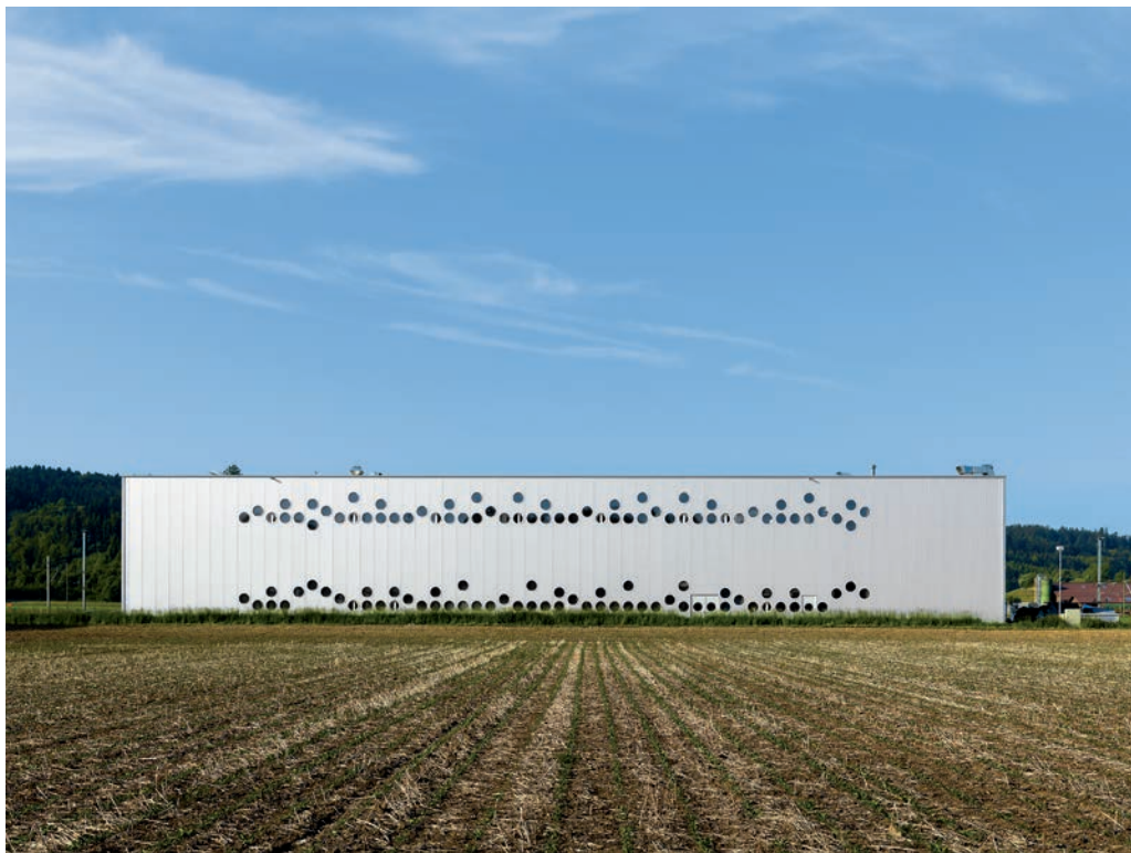
Die Fenster lochen die Fassade der Werkhalle in Schüpfen markant.
