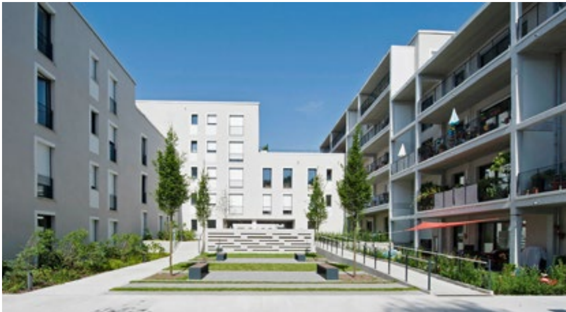
Die ABG Frankfurt Holding hat in der Metropole Frankfurt und im Rhein-Main-Gebiet bereits über 2500 Mehrfamilienhäuser im Passivhausstandard gebaut.
